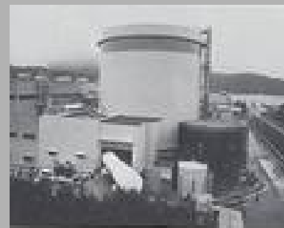
蒸気発生器取替工事 県内7発電所（H5～H9）
