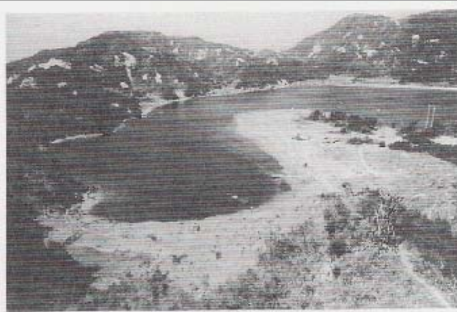
美浜発電所 (美浜町丹生地区)
