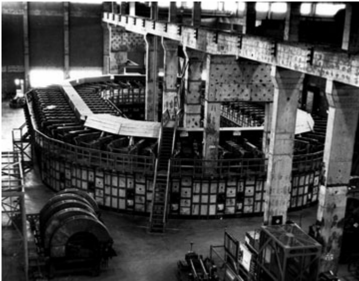
電磁法濃縮工場内部
