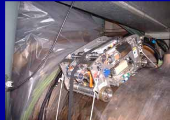
大飯1号機、大飯2号機
