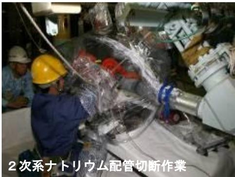
2次系ナトリウム配管切断作業
